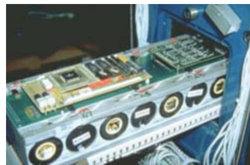
Fig.2 : Une partie du tiroir à l'entrée d'un module du TileCal. On peut voir les cartes HV_MICRO et HV_OPTO et 7 PMTs.
